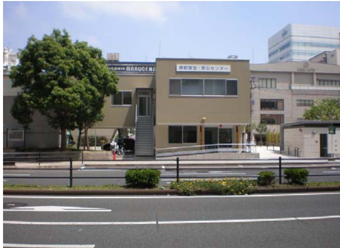
平成21年5月15日に開所した堺町特別対策隊の活動拠点である「堺町安全・安心センター」
