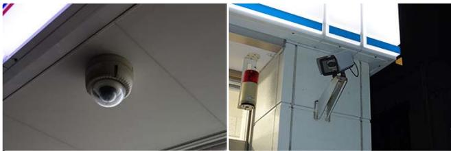
写真-1 ドーム型カメラ 写真-2 ボックス型カメラ
